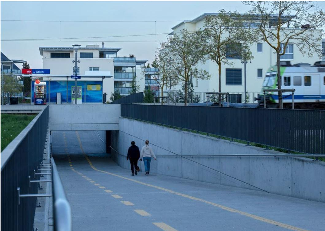
**Massnahmenbeschreibung** Realisierung einer zweiten Bahnunterführung zur Verbesserung der Verkehrsdrehscheibe Bahnhof Lyss (Regionaler Knoten). Die neue Unterführung schafft eine zusätzliche Verbindung für den Fuss- und Veloverkehr zwischen Zentrum/Bahnhof und den ostseitigen Quartieren und verbessert den Zugang zu den Perronalagen und zum Bushof.
