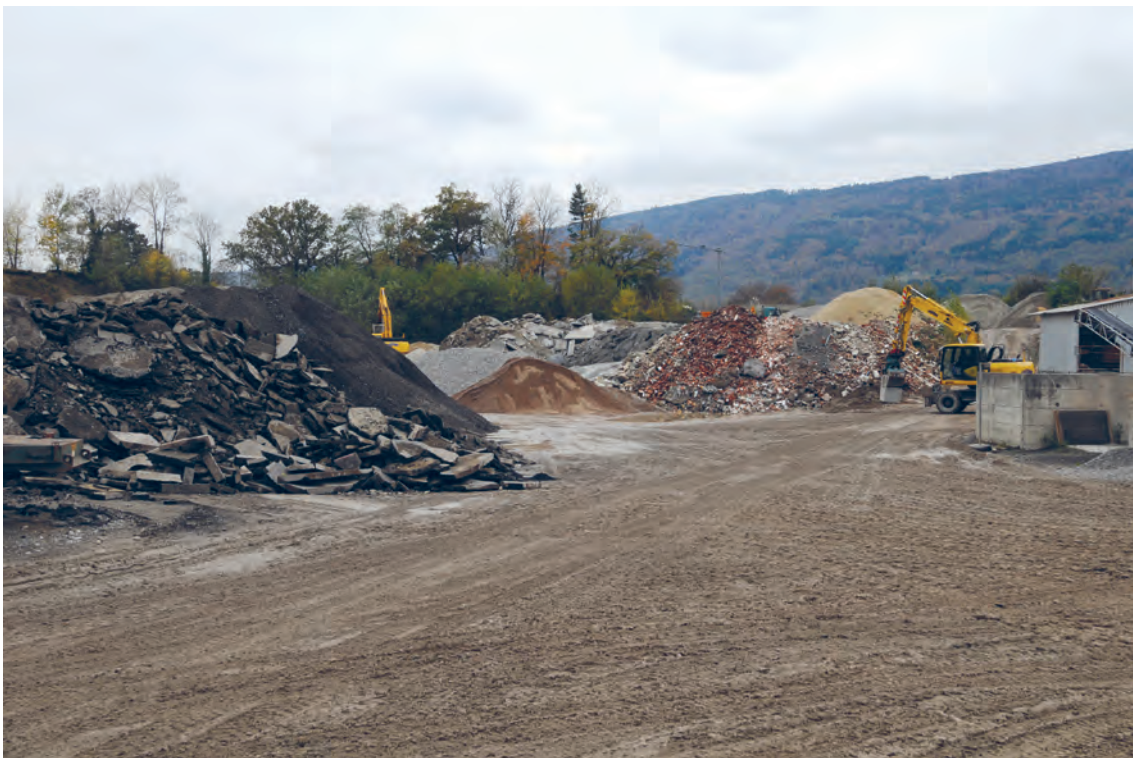
Fig. 3: Espace pour un recyclage opportun de gravats (Sutz).
