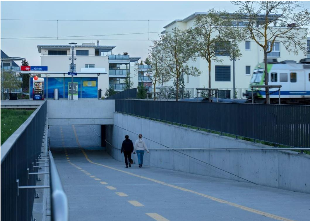
**Massnahmenbeschrieb** Neue Bahnunterführung nördlich der bestehenden Unterführung zur Verbesserung der Durchlässigkeit über die Bahnlinie zwischen dem Zentrum / Bahnhofplatz und den ostseitigen Quartieren und der Anbindung der Perronanlagen und des Busbahnhofs.
