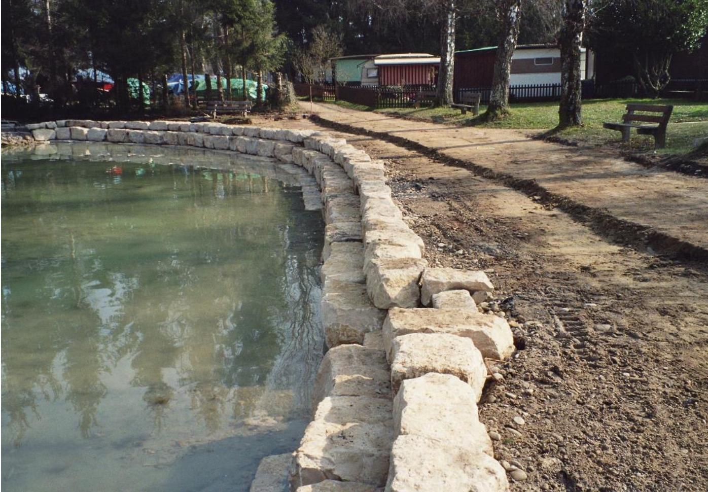
Sanierung Ufer Martibucht Erlach
