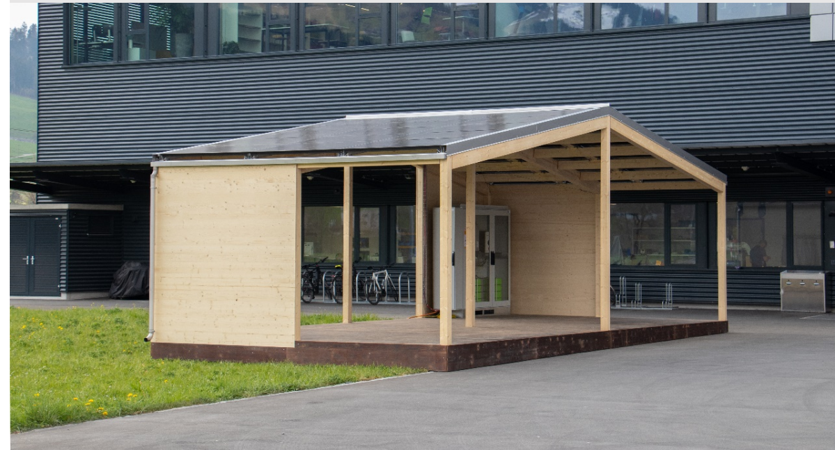
Solarpavillon Nachhaltige Eventinfrastruktur
